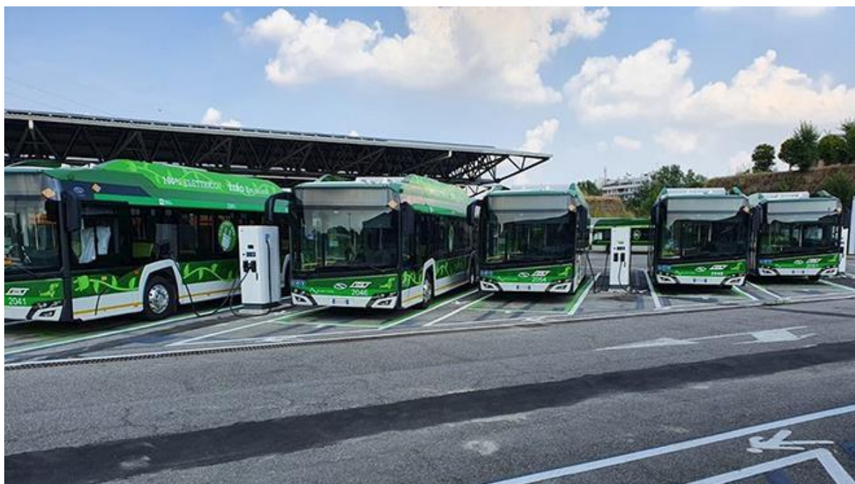
Foto 4: Petak Pengecasan Bas Elektrik
